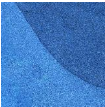
Ryc.19. Nawierzchnia bezpieczna EPDM, wylewana na miejscu, miejsce łączenia dwóch odcieni wybranego koloru
